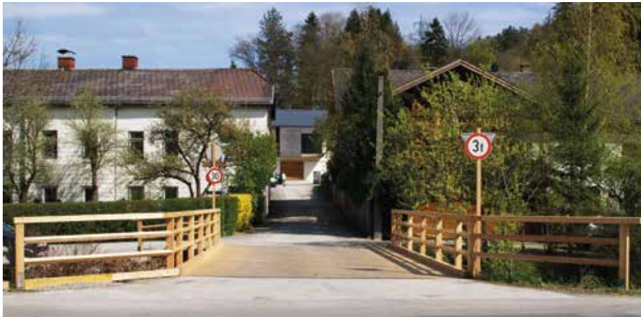
Brücke zwischen Ramsauer Straße und Bräuhausgasse
