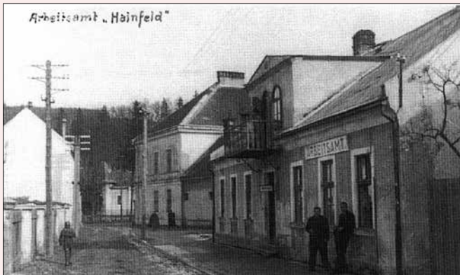
Abb. 13: Die Arbeitslosigkeit brachte große Not, Arbeitsamt in Hainfeld
