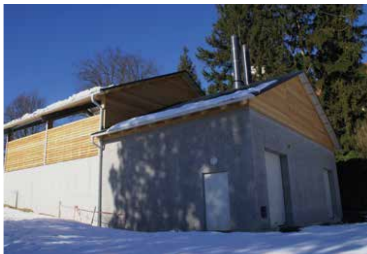
Elektrotankstelle am Gemeindeparkplatz und das Heizwerk »Nahwärme« der Firma Lux neben der Pfarrkirche
